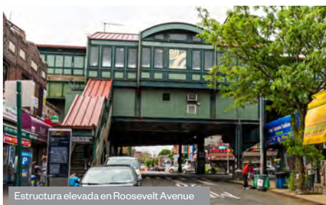
Estructura elevada en Roosevelt Avenue
