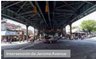
Intersección de Jerome Avenue
